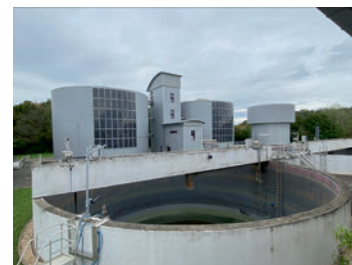
Bild 3: Schlammfäulung: Von Faultürme und Voreindicker...
