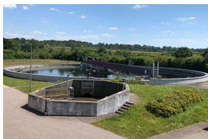
Das Nachklärbecken (Bild: WAD GmbH)
