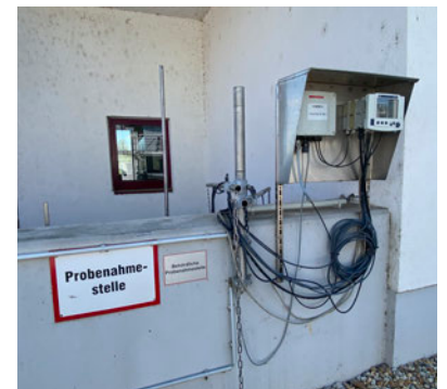
Probenentnahmestation für die finale Kontrolle des Wassers, ... (Bild: WAD GmbH)
